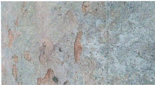
Foto No 03. Sustrucion de piso de torta de concreto
