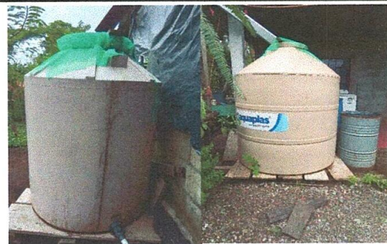
Foto No 06: Sustrucion de tinacos
