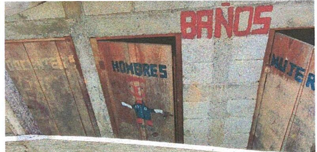
Foto No 02: Sustrucion de inodoros y puertas
