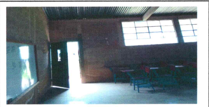
Foto 5: Pintura en muros exteriores e interiores
