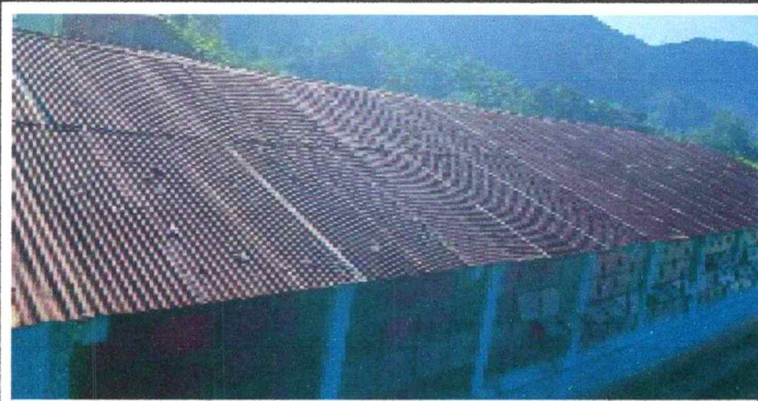
foto 1: Sustitución de lámina, por lámina troquelada aluzinc calibre 26, sustitución de capote de lámina para lámina troquelada y sustitución de elementos de fijación.
