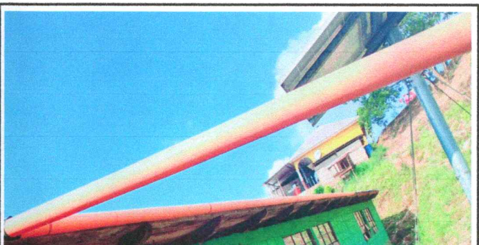
Foto 4: Sustitución de canal de pvc por canal de metal (calibre 3.63), reparación de bajada de agua pluvial, tubo PVC 3" y sustitución de soporte o pescante de metal para canal.
