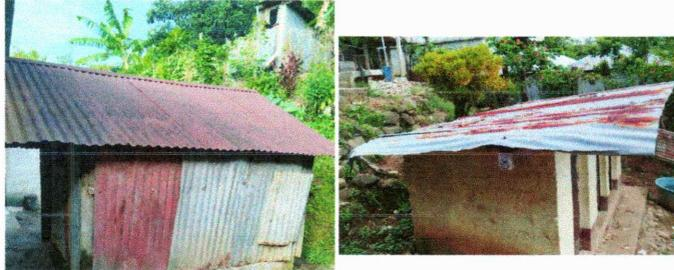
Foto 1: sustitución de lámina por lámina troquelada.
