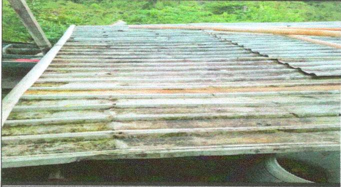
Foto1: sustitución de lámina, por lámina troquelada Aluzinc 16.
