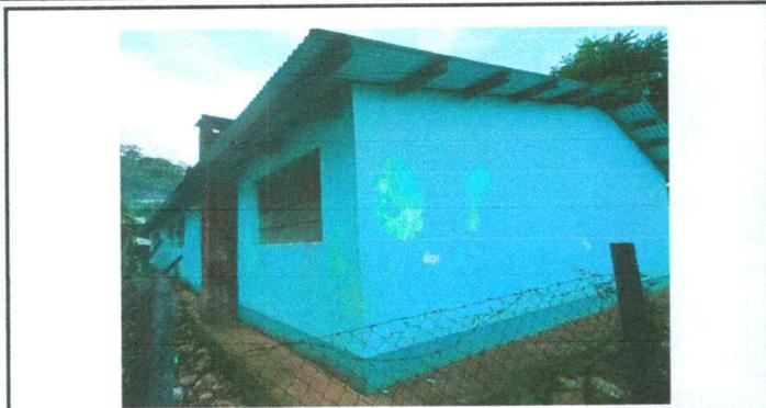
Foto No. 1: Cambio de láminas en mal estado por láminas troqueladas.
