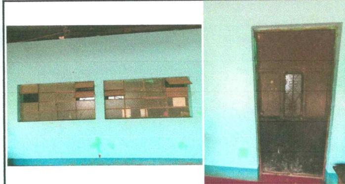
Foto No. 2: Cambio de ventanas y puertas en mal estado.
