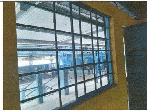
FOTO 4. Sustrucción de estructura de metal de ventana (MODIFICACIÓN A VENTANAS CORREDIZAS)
