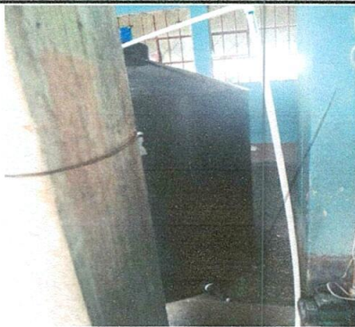
FOTO 5. Sustrucción de tubería línea principal.
