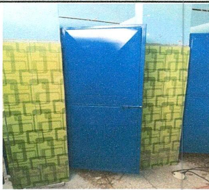
FOTO 3. Sustrucción de puertas en servicios sanitarios
