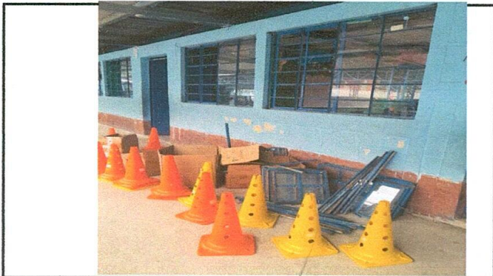
FOTO 4. Sustitución de estructura de metal de ventana (MODIFICACIÓN A VENTANAS CORREDIZAS)
