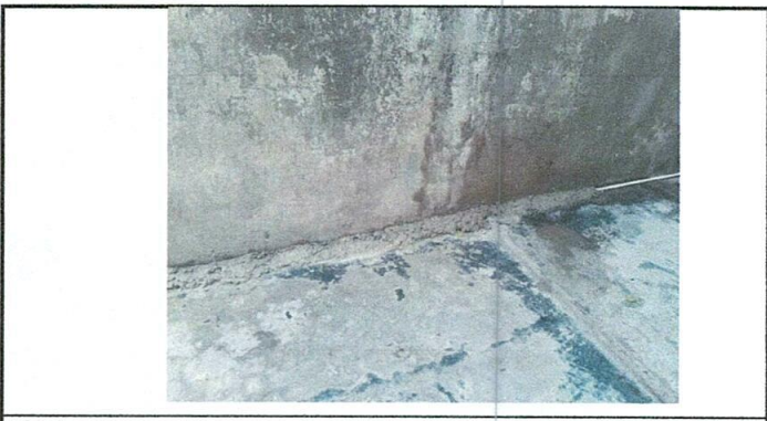
FOTO 5. Sustitución de tubería línea principal.
