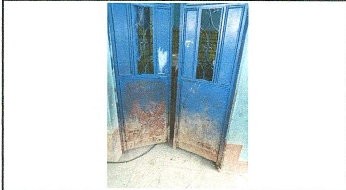
FOTO 2. Sustitución de puerta
