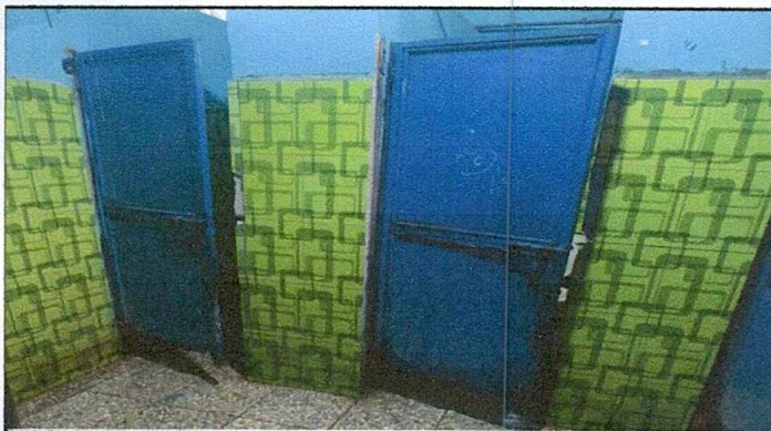
FOTO 3. Sustitución de puerta en servicios sanitarios
