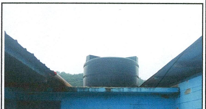
FOTO 6. Sustitución de depósito de agua 1700 lt
