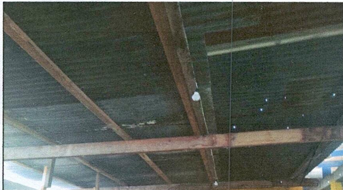
FOTO 1. Sustitución de lámina, por lámina troquelada aluzinc calibre 26 y Sustitución de estructura de soporte de madera, por metal
