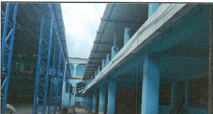
FOTO 5. Sustitución de tubería línea principal
