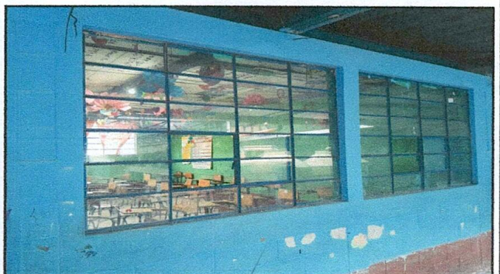
FOTO 4. Sustitución de estructura de metal de ventana (MODIFICACION A VENTANAS CORREDISAS)
