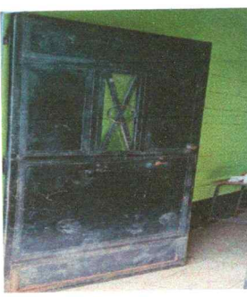
Foto No. 3: Sustitución de puerta en mal estado.
