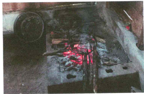
Foto No. 6: Sustitución de estufa rural completa.
