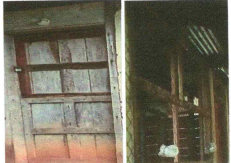
Foto No. 2: Sustitución de puertas y ventanas.
