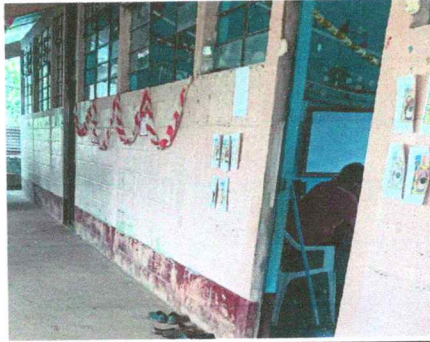
Foto No. 4: Pintura en paredes exteriores e interiores.
