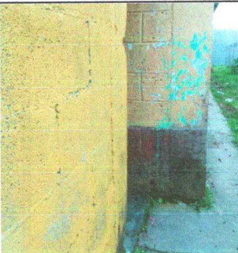
Foto 5: Pintura en muros exteriores e interiores.
