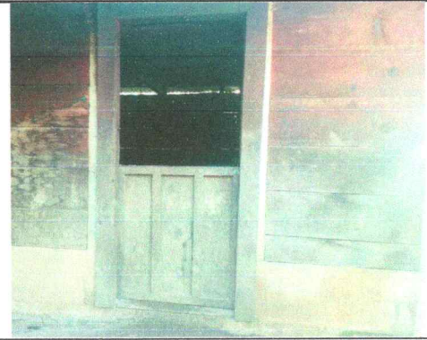
Foto 4: Sustitución de puerta.
