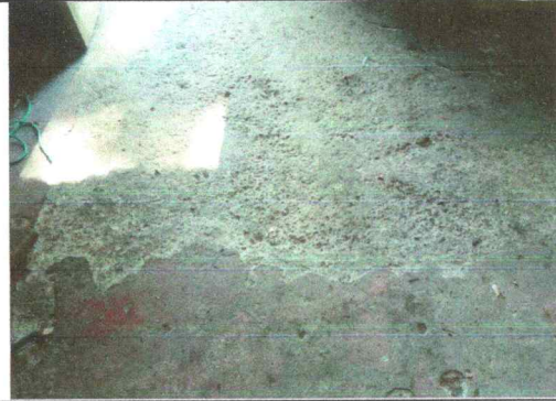
Foto 6: Sustitución de piso granito.
