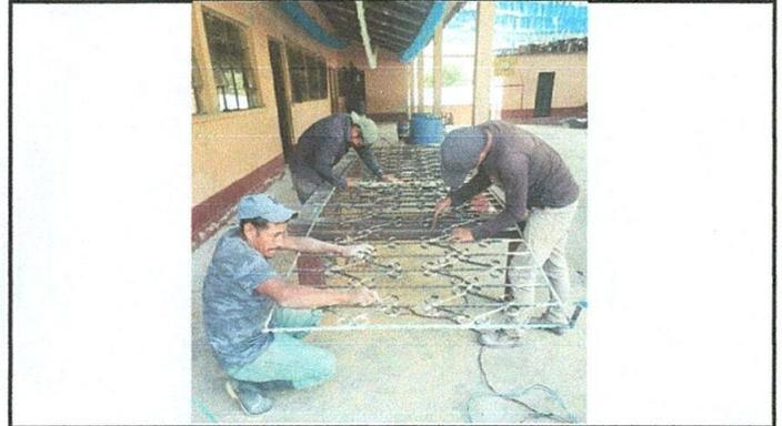
Foto 2: Sustitución y mantenimiento de balcones de ventana de metal.
