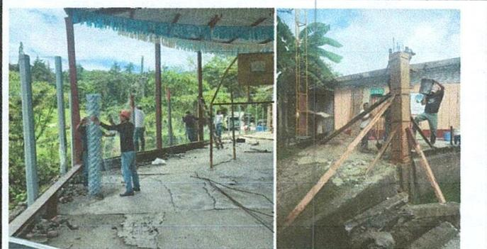
Foto 5: Reparación de muro de contención.
