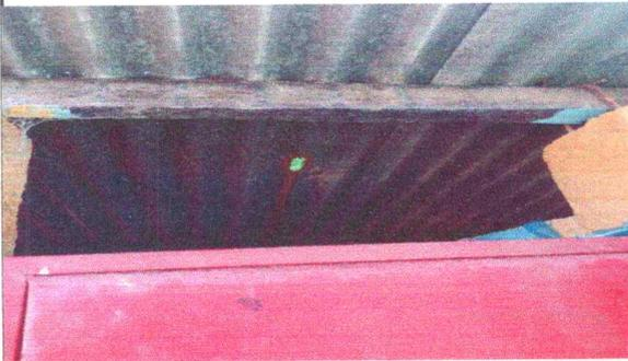
Foto 1: CUBIERTA DE LAMINA. Sustritucion de láminas acanaladas simples por láminas troqueladas de baños
