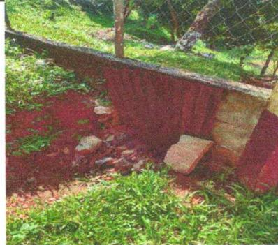
FOTO 13: Reparación de muro perimetral de bloc.
