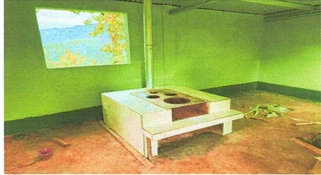
Foto 2: Sustitución de plancha y tubo de chimenea, sustitución de torta de cemento
