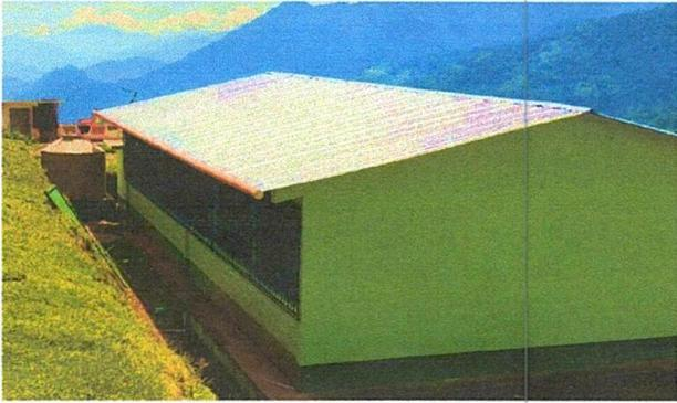
Foto 1: Sustitución de lamina troquela por lamina troquelada e implementación de canal de metal para captación de aguas pluviales con rotoplas de 2,500 litros
