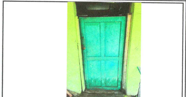
Foto No. 2: Sustrucción de puerta y chapa.
