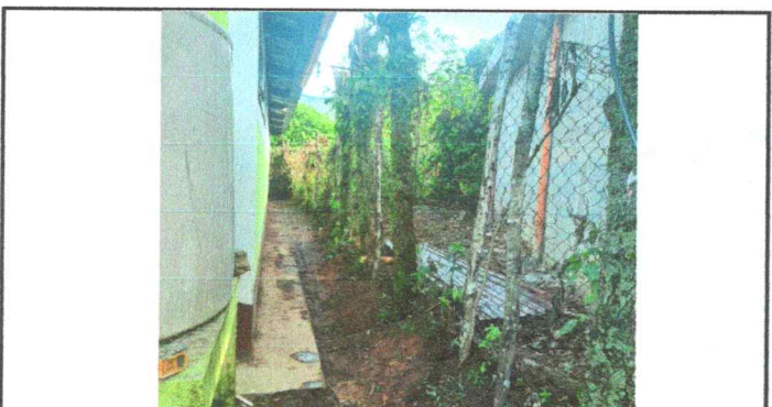
Foto No. 5: Sustrucción de muro perimetral de madera a concreto y malla por soleras.
