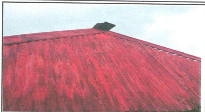
Foto 2: sustitucion de láminas por láminas troqueladas
