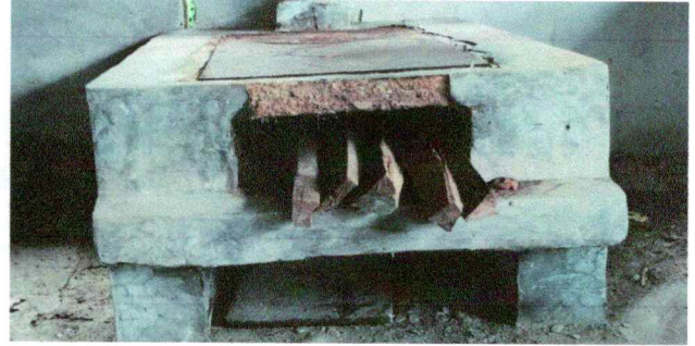
Foto 8: Sustitución de estufa rural (completa) incluye chimenea y plancha de metal
