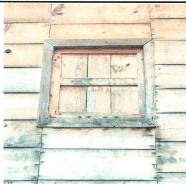
Foto 4: Sustitución de ventanas de madera por metal mas vidrio
