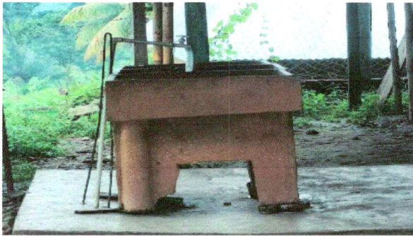
Foto 9: Sustitución de pila de cemento de dos lavadero
