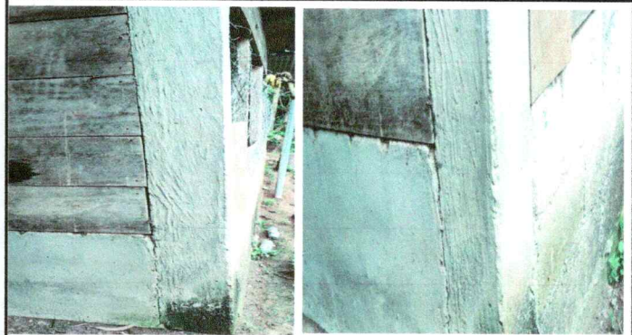
Foto 10: Sustitución de tablas, por block en cocina
