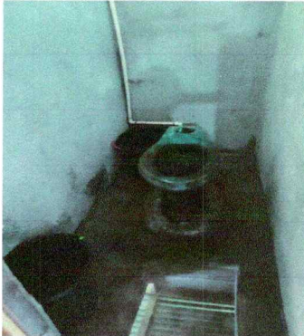
Foto 7: Sustitución de accesorios inodoro (tubo de abasto), Sustitución inodoro y Sustitución de llave de paso
