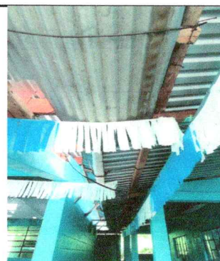
Foto 6: Sustitución de canal de pvc
