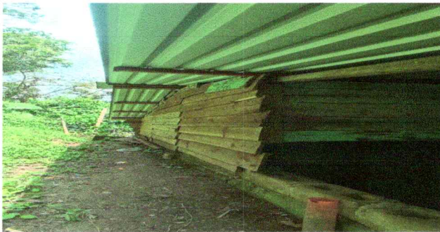
Foto 11: Sustitución de tablas, por block en bodega
