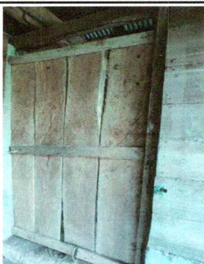
Foto 3: Sustitución de puerta de madera a metal
