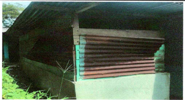
Foto 12: Sustitución de tablas y laminas por block en baños
