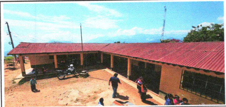
Foto1: Cubierta de lámina y capote
