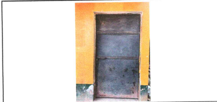
Foto 3: Sustitución de Puertas de metal
