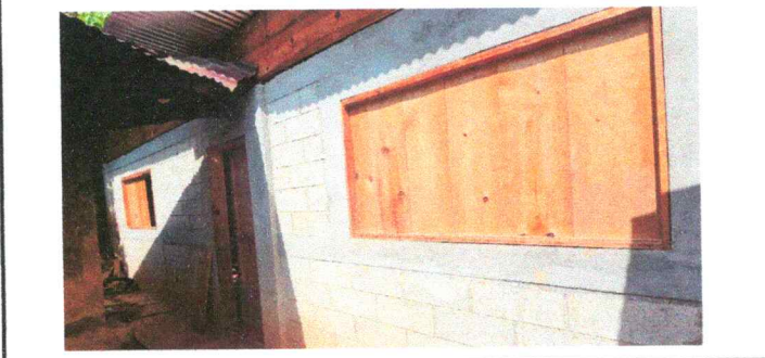
Foto 4: Sustitución de ventanas de madera por metal mas vidrio
