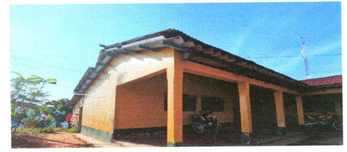
Foto 2: Mantenimiento de estructura de soporte de madera por metal
