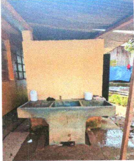
Foto7: Sustitución de pilas de cemento de 2 lavaderos
