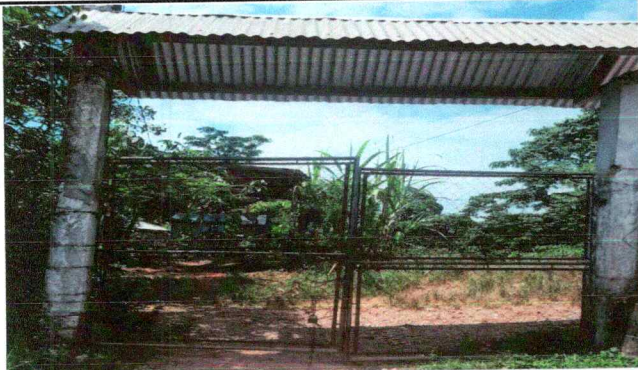
Foto 3: sustitución del porton principal del centro educativo por deterioro total.
