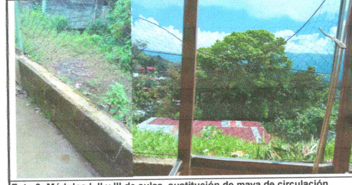
Foto 6: Módulos I, II y III de aulas, sustitución de maya de circulación.
