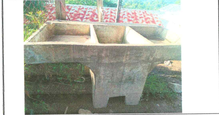
Foto 4: Sustitución de pila por nueva ya que la existente se encuentra muy deteriorada.
