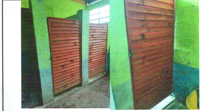
Foto 2: Sustitución de puertas de madera de los sanitarios por puertas de metal (1.60m x 0.70m)
