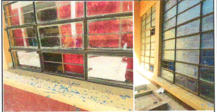
Foto 8: Sustitución de vidrios de ventanas de metal
