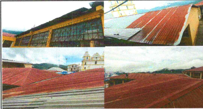
Foto1: Sustitución de Lámina en malas condiciones
