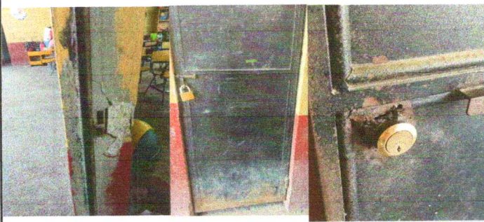
Foto7: Sustitución de 3 puertras de metal
