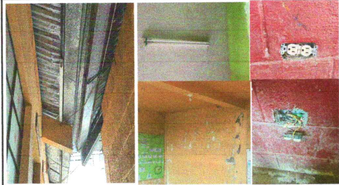
Foto 9: Sustitución de lámparas 2 x 40 por focos ahorradores, de plafoneras y de tomacorrientes dobles
