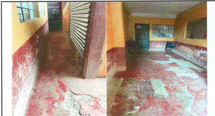
Foto 3: Sustitución de piso de torta de concreto
