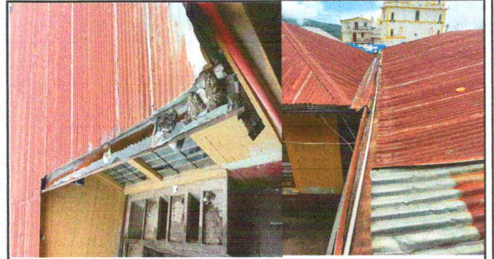
Foto 4: Sustitución de canales de metal y bajadas de agua pluvial de tubo PVC de 3"
