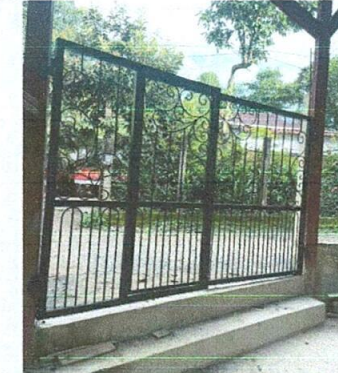
Foto No. 4: Sustitución de portón de metal.
