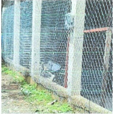
Foto No. 7: Reparación de muro perimetral con malla galvanizada.
