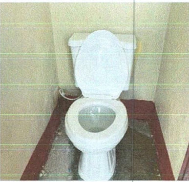
Foto No. 3: Sustitución de inodoro.
