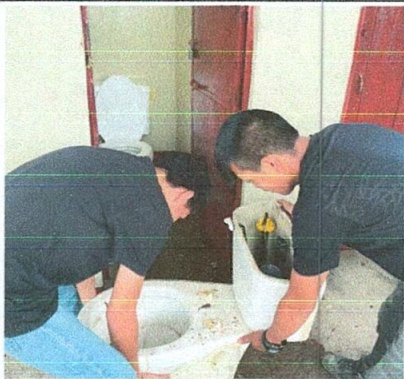
Foto No. 3: Sustitución de inodoro.
