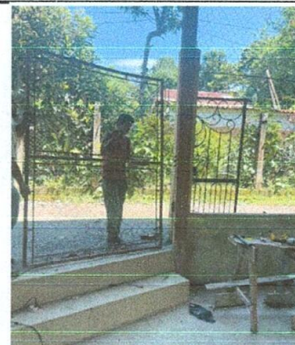
Foto No. 4: Sustitución de portón de metal.
