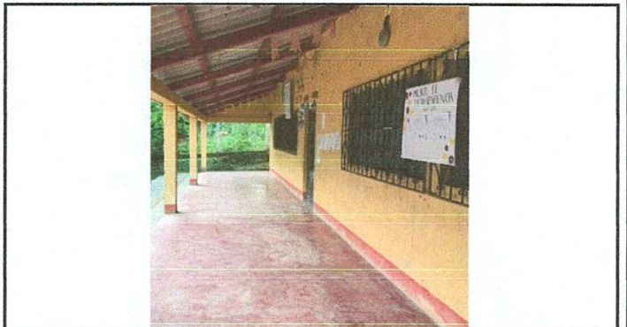
Foto No. 6: Pintura en paredes exteriores e interiores.
