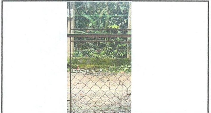
Foto No. 4: Sustitución de portón de metal.
