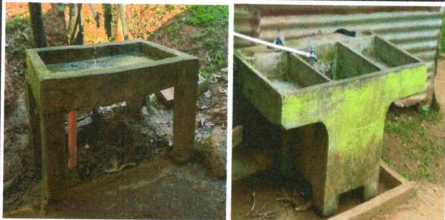
Foto 3: Sustitución de lavamano de concreto por pila y sustitución de pila de concreto de dos lavadero.
