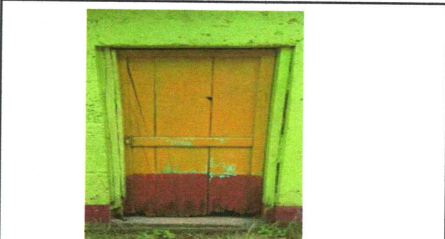
Foto 10: Sustitución de puerta de madera por metal.
