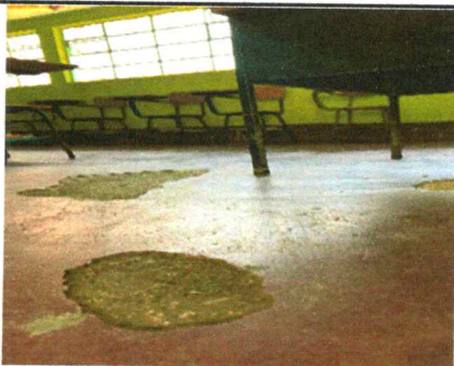
Foto 5: Reparación de piso de torta de concreto en aulas.
