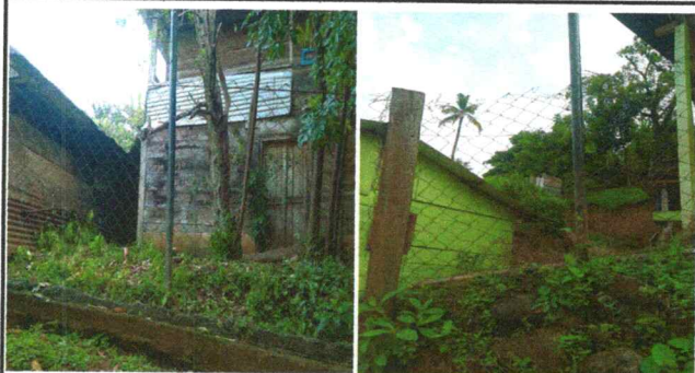
Foto 7: Reparación de tubo hg y malla galvanizada.
