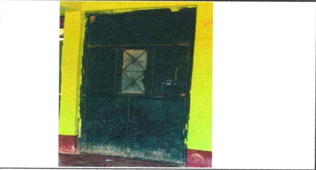
Foto 11: Mantenimiento de estructura.
