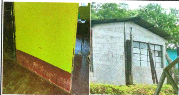
Foto 4: Pintura en muros exteriores e interiores.
