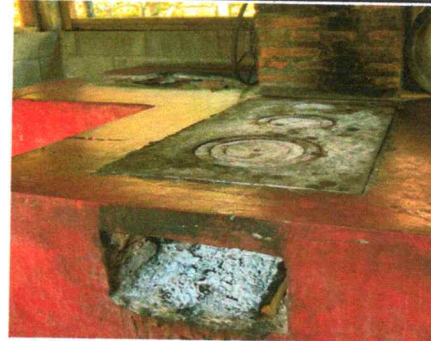
Foto 2: Sustitución de plancha artesanal completa.
