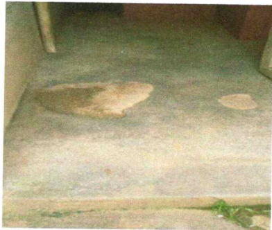
Foto 1: Mejoramiento de piso de concreto en cocina.
