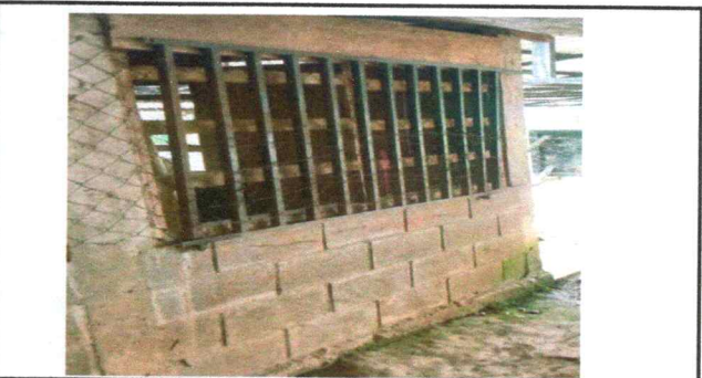
Foto 12: Sustitución de balcones de metal 1.20 x 1.28 metros.
