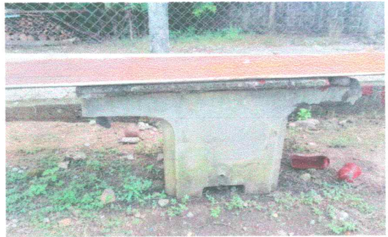
Foto10: Sustrucción de pila plástica de dos lavaderos
