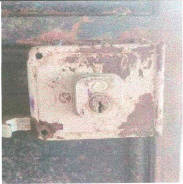
Foto9: Sustrucción de chapas en puerta de metal
