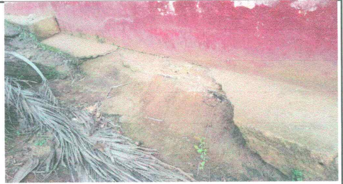
Foto8: Reparación de banquetas de concreto
