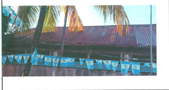
Foto 2: Sustrucción de lámina, por lámina troquelada calibre 26
