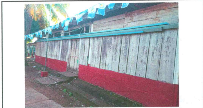
Foto1: Sustrucción de pared de madera por block
