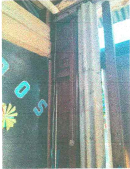
Foto7: Sustrucción del ducto electrico y sus accesorios
