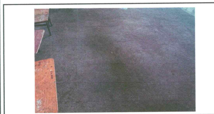
Foto 5: Sustrucción de piso de concreto
