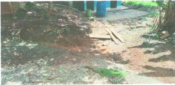
Foto11: Reparación de cuneta de concreto
