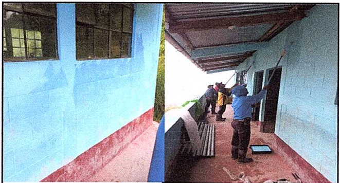
Foto 4: pintura en mal estado
