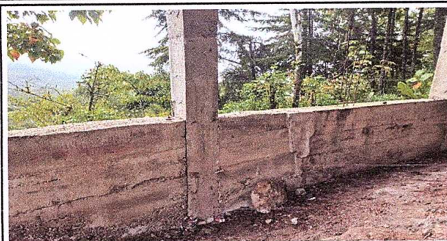
Foto 1: cocina a medio construir pendiente, pared, piso puertas y ventanas
