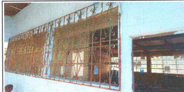
Foto 5: VENTANAS. Sustitución de vidrios de 53x29 centímetro cada vidrio
