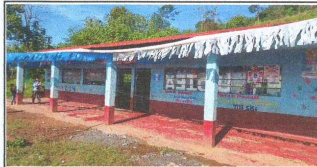
Foto 10: PINTURA EN PAREDES EXTERIORES E INTERIORES
