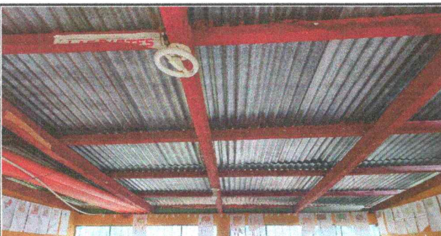
Foto 11: Sustitución de focos ahorradores
