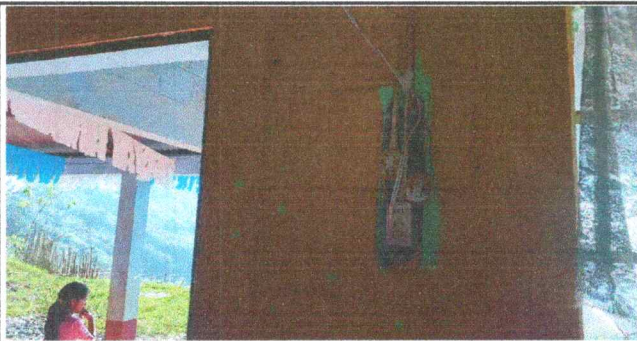
Foto 9: REPARACIÓN DE SISTEMA ELÉCTRICO. Sustitución de toma corrientes, interruptores, cables, focos, plafoneras y flípon
