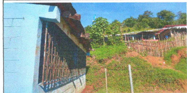
Foto 6: Mantenimiento a balcones de metal
