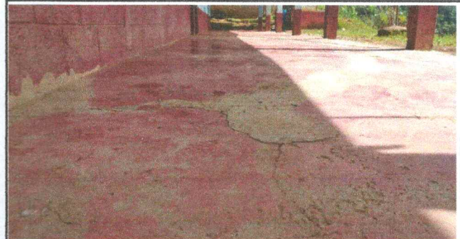
Foto 8: PISO. Sustitución de piso de torta de cemento para la cocina y tres aulas.
