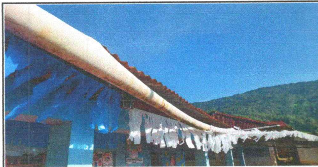
Foto 3: CANALES DE AGUA PLUVIAL. Sustitución de canales de pvc
