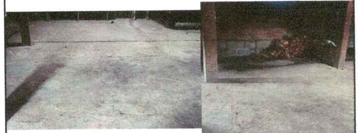
Foto 4: SUSTITUCIÓN DE PISO
