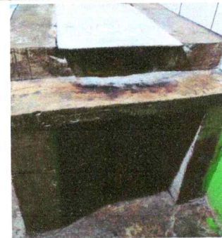
Foto 6: REPARACIÓN DE COCINA: SUSTITUCION COMPLETA DE ESTUFA RURAL
