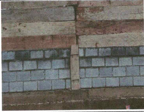
Foto 7: SUSTITUCIÓN DE PARED DE COCINA MADERA POR BLOCK
