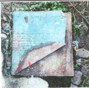
Foto 5: DRENAJE. SUSTITUCIÓN DE CAJA DE REGISTRO
