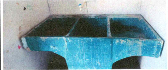
Foto 8: REPARACIÓN DE COCINA: PILA DE CEMENTO DE DOS LAVADEROS
