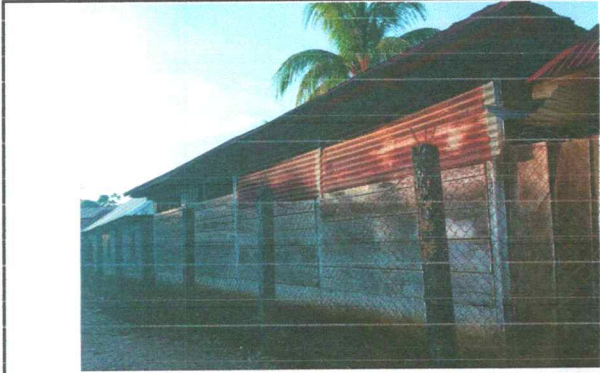
Foto 1: Sustrucción de pared de madera por block
