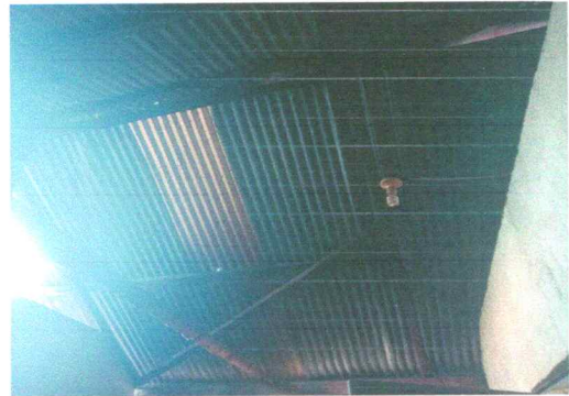
Foto 2: Sustrucción de lámina, por lámina troqueada calibre 26
