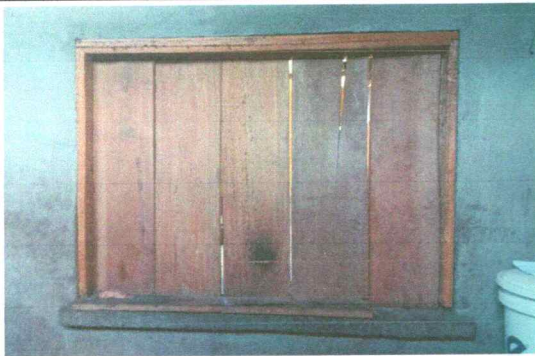
Foto 3: Mejoramiento de ventanas de hierro
