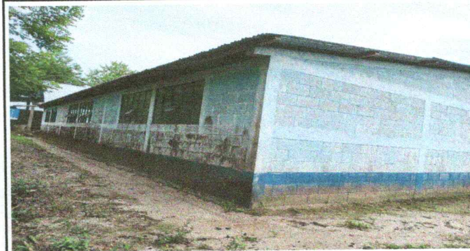
Foto 4: Pintura en muros exteriores e interiores.
