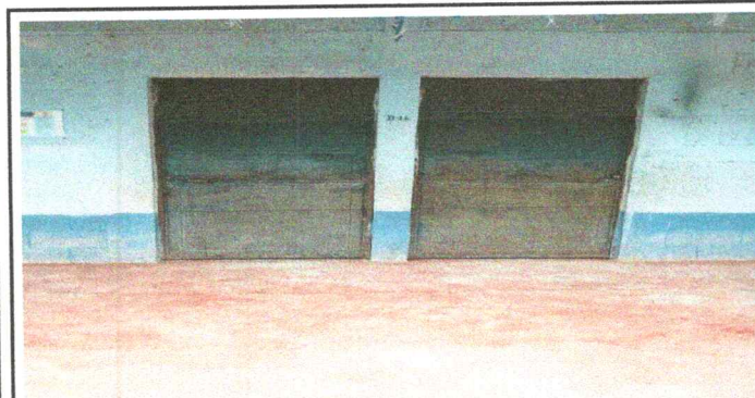
Foto 3: Sustitución de puertas.
