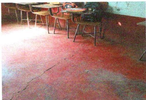
Foto 5: reparación de piso en mal estado por piso granito
