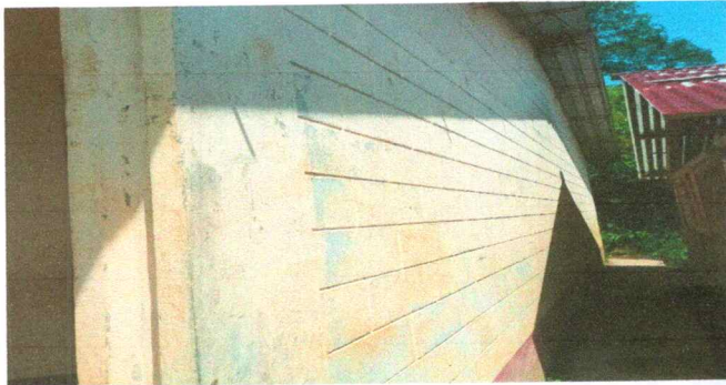
Foto 9: PINTURA EN MUROS EXTERIORES E INTERIORES
