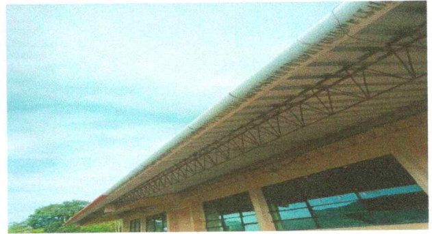
Foto 8: SUSTITUCION DE CANALES POR MALAS CONDICIONES
