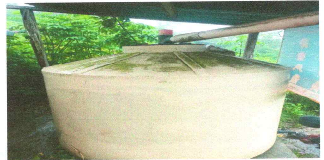
Foto 10: SUSTITUCION DE DEPOSITO DE AGUA POR MAL ESTADO
