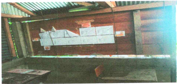
Foto 11: SUSTITUCIÓN DE PARED DE MADERA POR BLOCK
