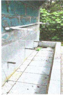
Foto13: sustitución de llave de chorro.
