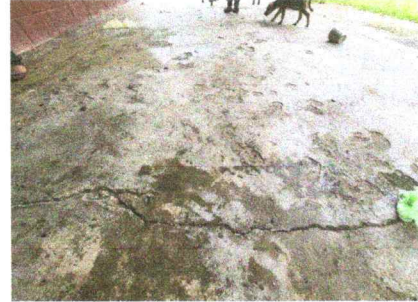
Foto 14: reparación de planchas de concreto de patio.
