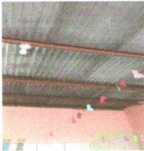
Foto 17: reparación de cableado electrico.
