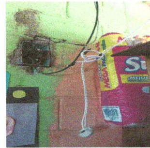
Foto 16: sustitución de tablero de flipones.
