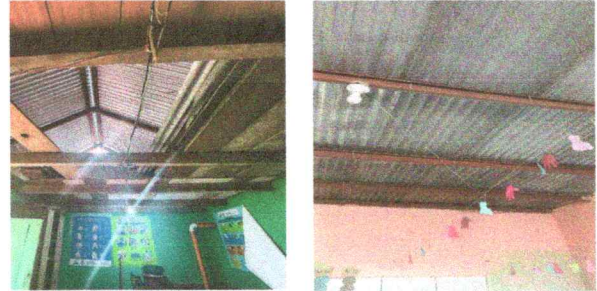
Foto 18: sustitución de conducto eléctrico
