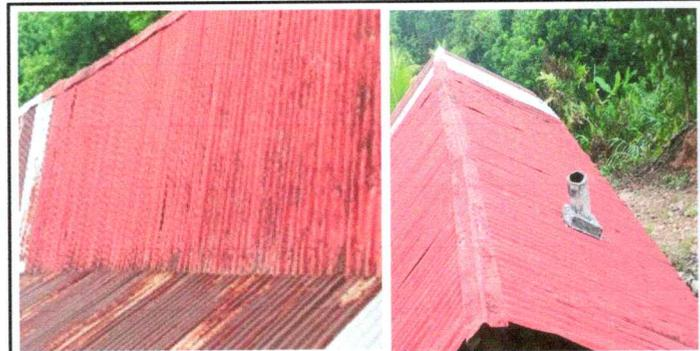
Foto 5: Sustrucción de lamina, por lamina troquelada calibre 26
