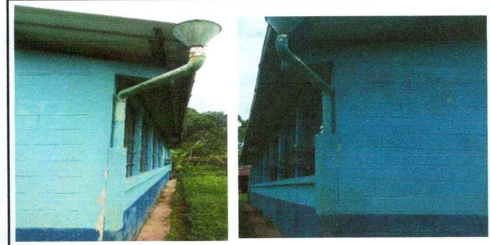
Foto 6: Reparacion de bajada de agua pluvial, tubo PVC 3"
