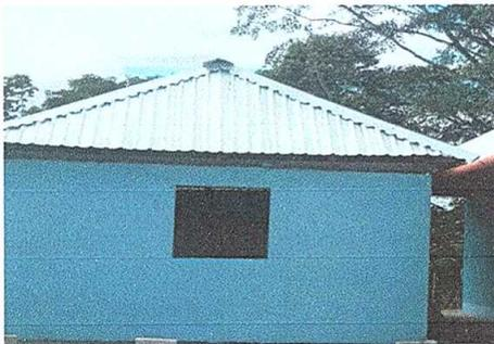
Foto 5: Sustitución paredes de madera por block
