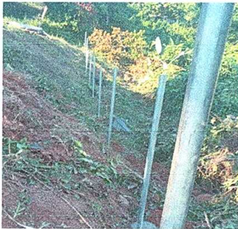
Foto 3: Sustitución de Tubo hg y malla galvanizada
