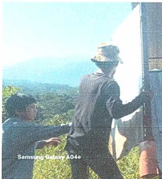
Foto 3:Sustitución de puertas en servicios sanitarios
