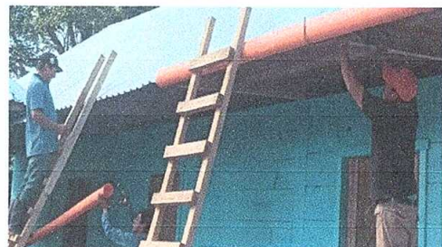
Foto 6: Sustitución de canales de agua pluvial de PVC
