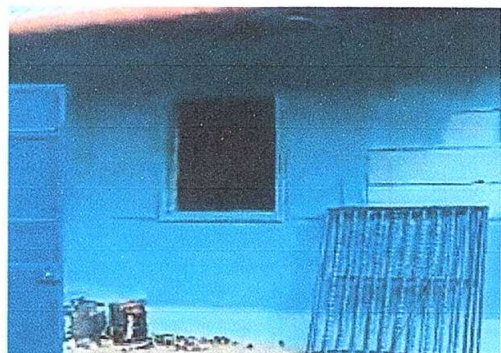
Foto 4: Mejoramiento de Ventanas 1.5 mts. x 1mt.
