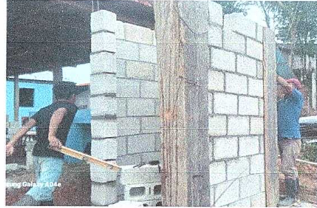
Foto 2: Mejoramiento de baño
