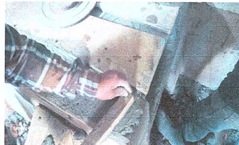
Foto 6: Sustitución de plancha de metal de 3 hornillas
