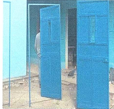
Foto 2:Mejoramiento de puertas de madera de 2 mts. x 1 mt.
