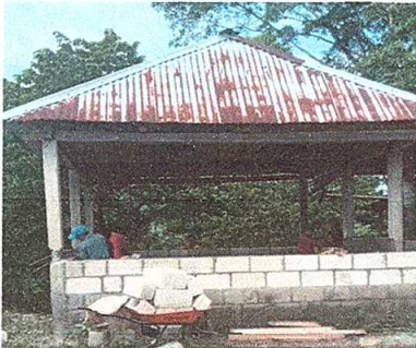
Foto 5: Sustitución paredes de madera por block
