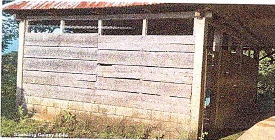
Foto 5: Sustitución paredes de madera por block
