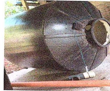
Foto 4: Sustitución de depósitos de agua 1700 lt.
