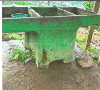
Foto No. 8: Sustitución de pila por nueva, ya que la existente se encuentra deteriorada.
