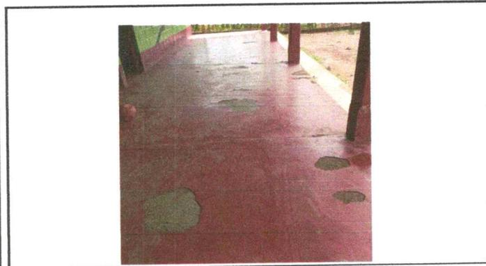
Foto 3: piso concreto en malas condiciones
