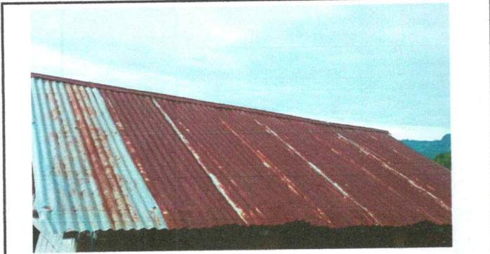
Foto 1: Sustitución de lámina en malas condiciones por lámina troquelada Aluzinc calibre 26
