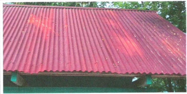
Foto 1: sustitución de lámina, por lámina troquelada (cocina)
