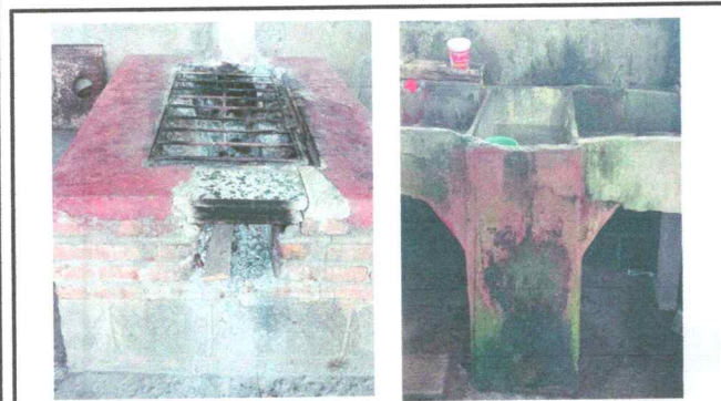
Foto 9: sustitución de plancha, pila y pared de madera por block
