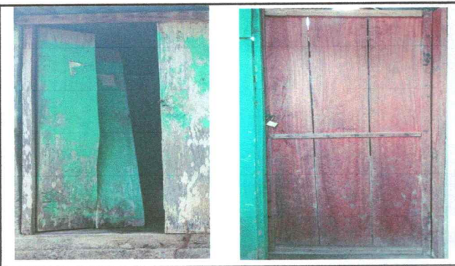
Foto 3: sustitución de puertas
