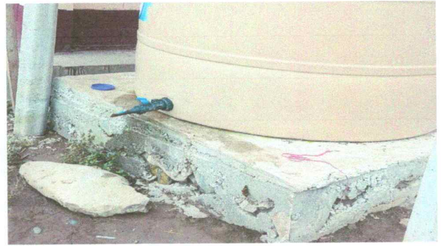
Foto 8: sustitución de depósito de agua
