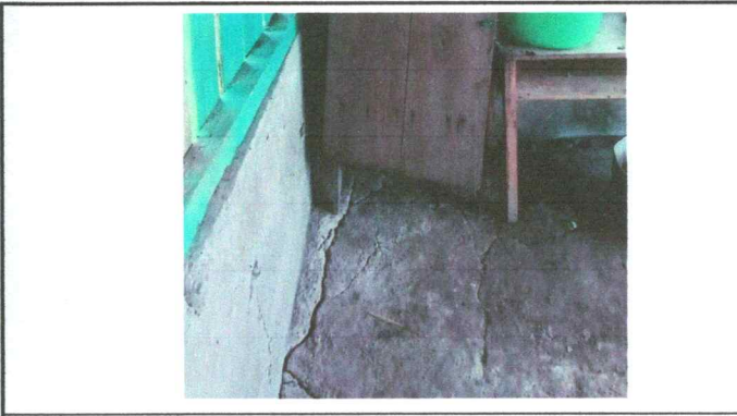
Foto 4: sustitución de piso de torta de concreto
