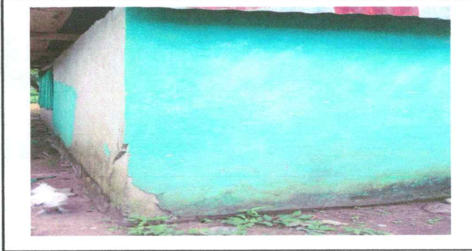
Foto 6: pintura en muros interiores y exteriores
