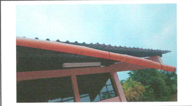
Foto 5: sustitución de canal de pvc
