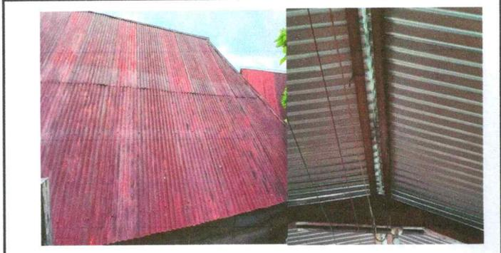
Foto No. 1: Sustitución de láminas en mal estado y techo por laminas nuevas laminas nuevas.
