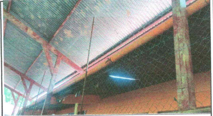
Foto 2: Sustitucion de canal
