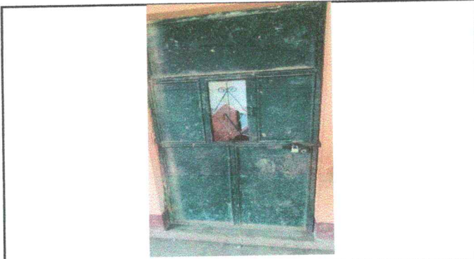
Foto 3: Sustitucion de puertas
