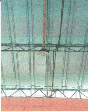
Foto 7: Reparación de sistema eléctrico
