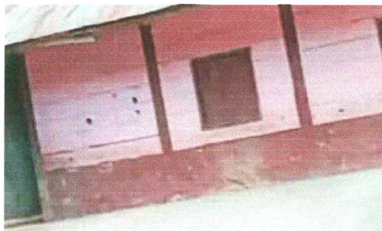
Foto No. 3: Sustitución de ventanas de madera por metal mas vidrio.
