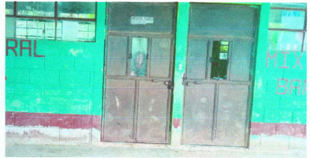
Foto 4: Sustitución de puertas de metal de 2.10 x 1 Metros2
