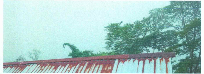
Foto 2: Sustitución de capote de lámina para lámina troquelada
