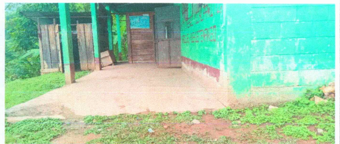
Foto 6: Reparación de piso de torta de concreto
