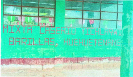
Foto 7: Pintura en muros exteriores e interiores.
