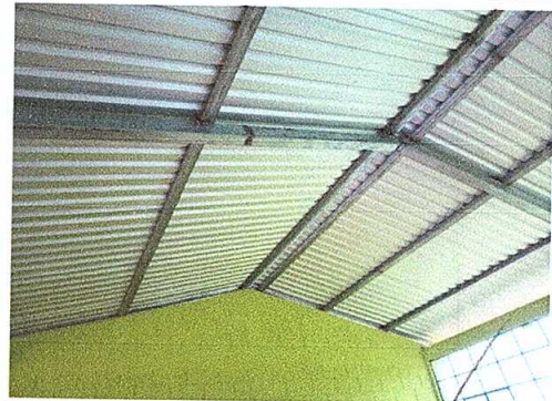
Foto No. 4 Sustitución de estructura de madera por metal.
