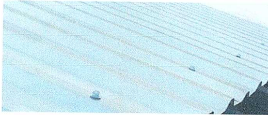
Foto No. 3 Sustitución de elementos de fijación.
