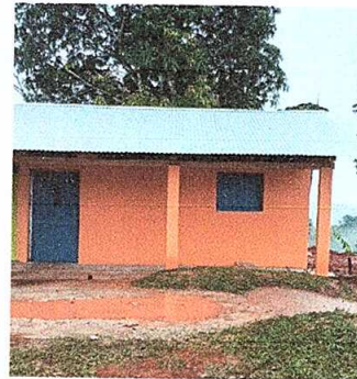
Foto No. 6 Reparación de cocina.
