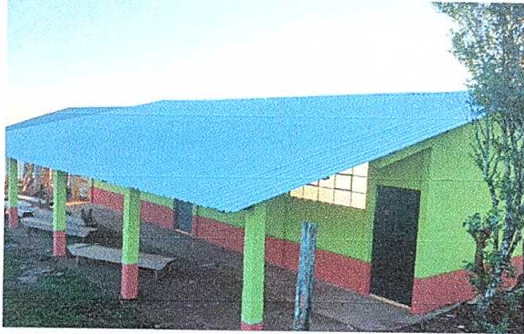
Foto No. 1 Sustitución de techo.
