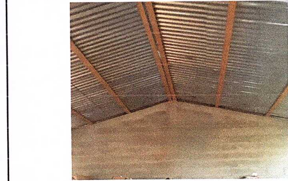
Foto No. 4 sustitución de estructura de madera por metal
