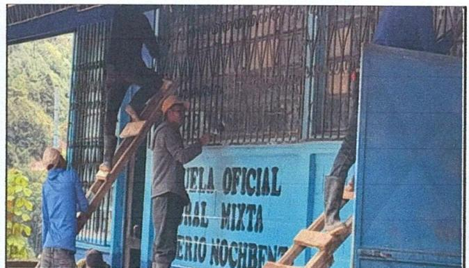
Foto 4: Mantenimiento de balcones de metal
