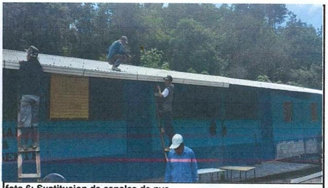
Foto 6: Sustitución de canales de pvc
