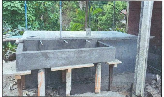
Foto 8: Sustitucion de depósito de agua
