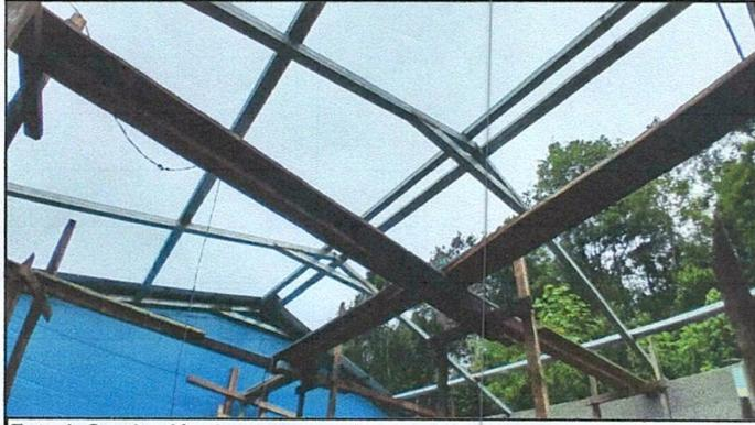
Foto 1: Sustitución de estructura de soporte
