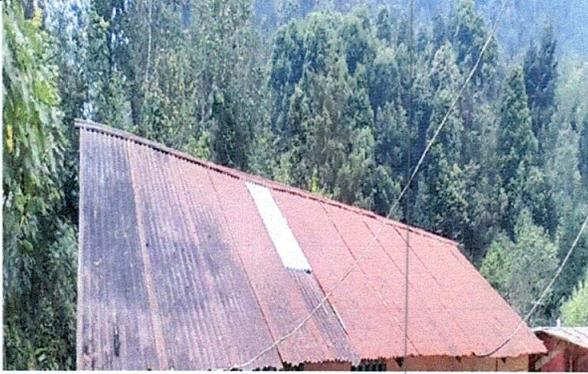
Foto 1: Láminas en malas condiciones
