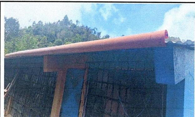
Foto 6: Sustitución de canales de pvc
