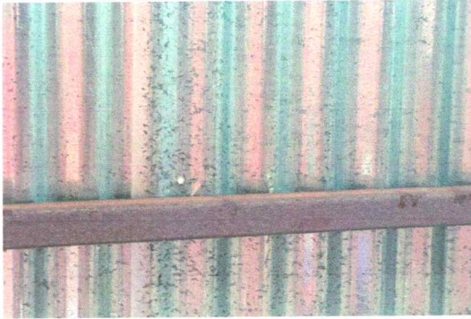
Foto1: SUSTITUCION DE LAMINAS PARA 1 AULA EN MAL ESTADO
