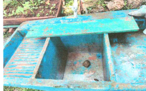
Foto 2: SUSTITUCION DE PILA EN MAL ESTADO
