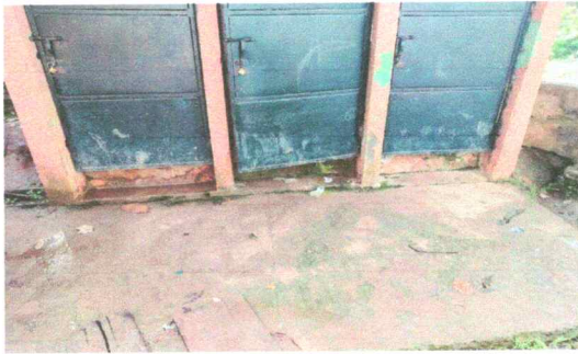
Foto 3: SUSTITUCION DE PISO DE BAÑO EN MAL ESTADO
